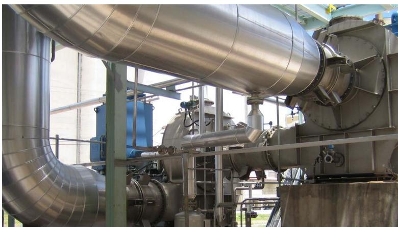
Тепловая функция конденсации этих парообразных потоков, которые были увеличены (сжаты) под давлением, впоследствии используется для нагрева в рамках процессов испарения. Эти процессы затем выполняются при более низком уровне температуры. Таким образом обеспечивается минимальный уровень потребления пара.
